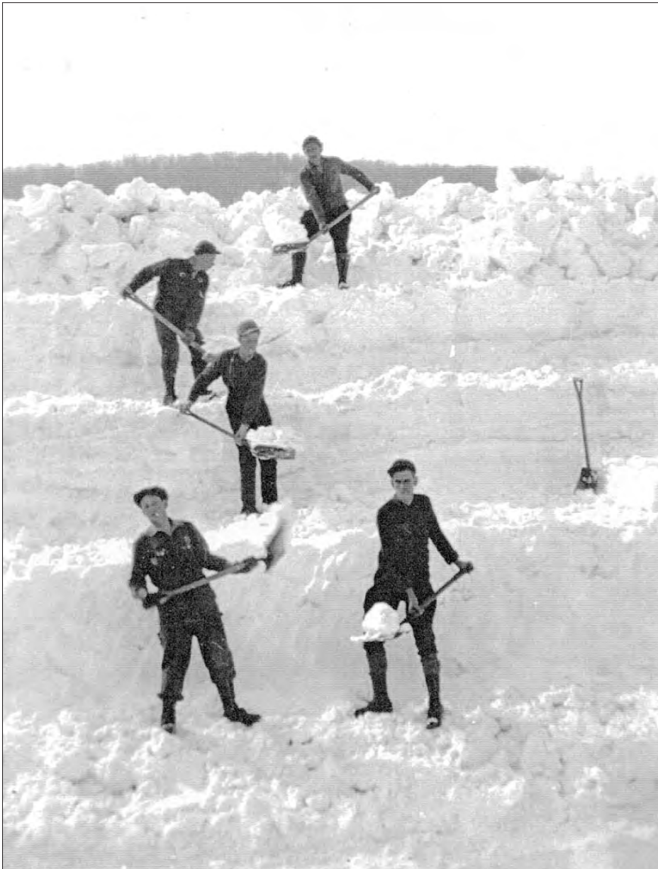
Vers la fin des années 1940, des hommes vigoureux maniaient la pelle pour déneiger la gare de triage de la gare de Prévost. En équipe, ils remontaient la neige jusqu'à 20 pieds de haut.
