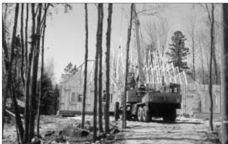
Cette construction à l'intention d'un propriétaire en fauteuil roulant comporte un seul étage, mais pour respecter le règlement d'urbanisme, la maison aura un faux toit créant une illusion de deux étages.
