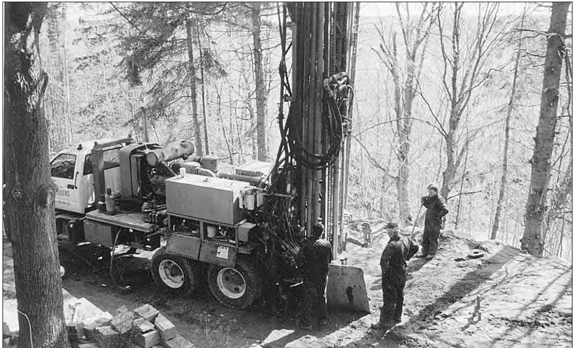
Les abonnés de l'aqueduc Dagenais, ont dû se résoudre à faire creuser leur propre puits. Une dépense importante, mais essentielle au maintien de la santé. Un des propriétaires du regroupement, M. Normand Taylor fait creuser son puits.
