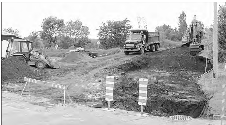
Plusieurs personnalités ont visité, mardi le 18 juin, deux importants chantiers, soit la virée Lesage près de la Caisse Populaire et le chantier de la rue des Frangins qui vise à éliminer la dangereuse dénivellation et faciliter l'entrée et la sortie de cette intersection donnant accès au Domaine des Patriarches.
