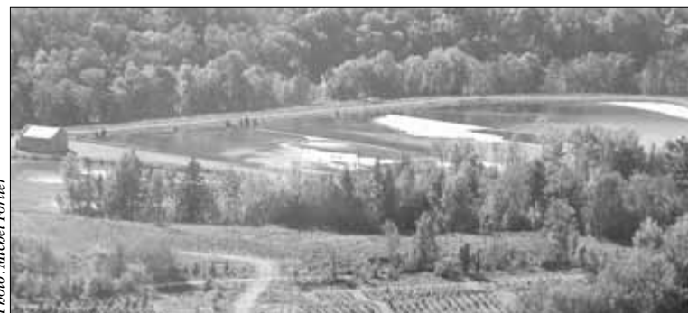
Les deux étangs aérés, d'une dimension de 10041 et 27015 mètres carrés, sont entretenus par la firme Simo Management. Ils sont couverts de végétation verte, qui démontre l'état de santé de l'étang.
