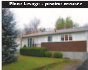
Place Lesage - piscine creusée
