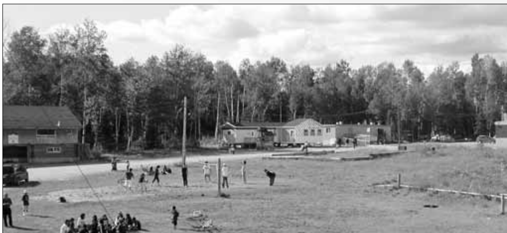
Vue d'ensemble du village de Kitcisakik: on y aperçoit la maison des jeunes, la garderie, les installations sanitaires, le centre de formation et le parc, pour lequel les autorités sont en attente de nouvelles infrastructures.
