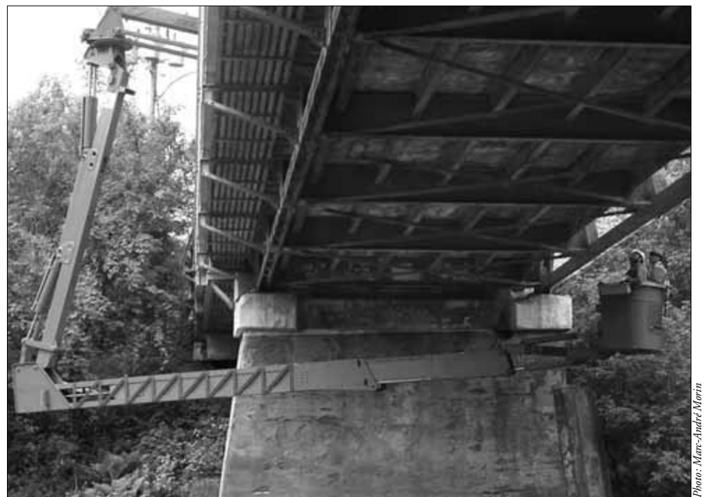
C'est à l'aide de ce bras mécanique très spécialisé, que les techniciens de la société JESNA ont inspecté les conditions de détérioration du pont. Mais d'après leur expertise, ils ont vu pire.
