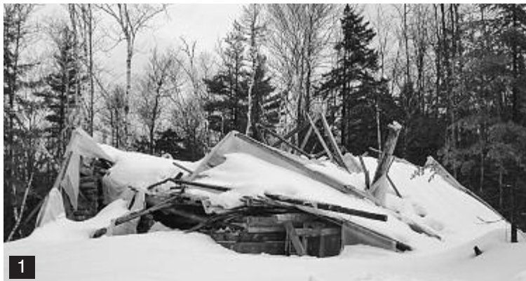
1. Maison en bois rond qui était en construction qui s'est écroulée sous le poids de la neige en janvier dernier. 2. L'intérieur du casse-croûte Chez Pajo détruit, sa toiture s'est effondrée le 9 mars dernier. 3. Toiture effondrée au 638, ch. Sainte-Anne-des-Lacs. 4. Façade du bâtiment au 636-638, ch. Sainte-Anne-des-Lacs.
