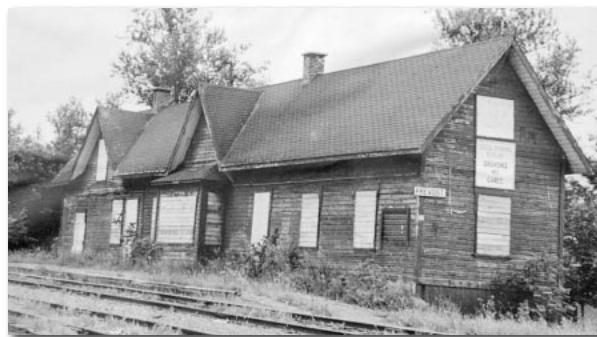
En 1980, le Canadien Pacifique prend la décision de cesser le service ferroviaire vers Mont-Laurier; le train ne reviendra plus à la gare de Prévost et le bâtiment sera laissé à l'abandon.
