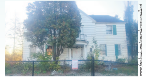
L'avis de démolition devant la maison Rolland à Saint-Jérôme
