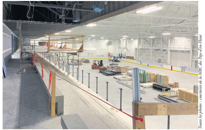
Les bandes sont pratiquement toutes installées et les travaux finaux vont bon train.
