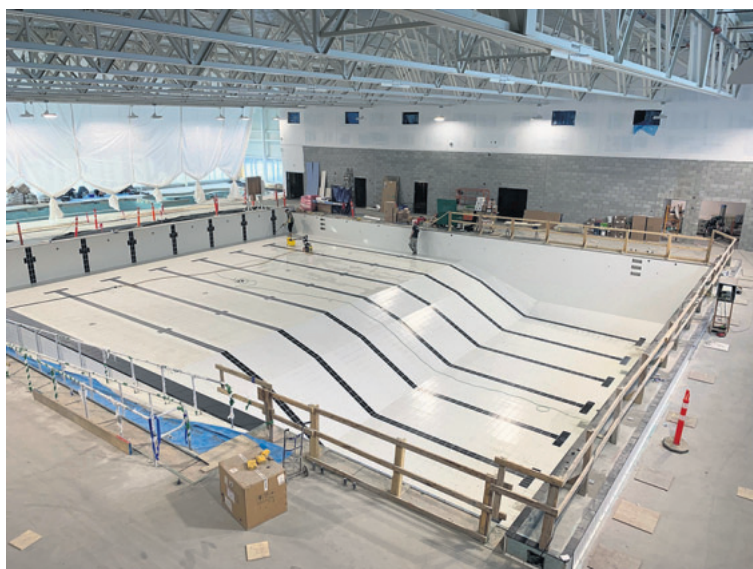
Les travaux de céramique se termineront sous peu dans la piscine semi-olympique qui attendra les baigneurs dès l'été 2022.
