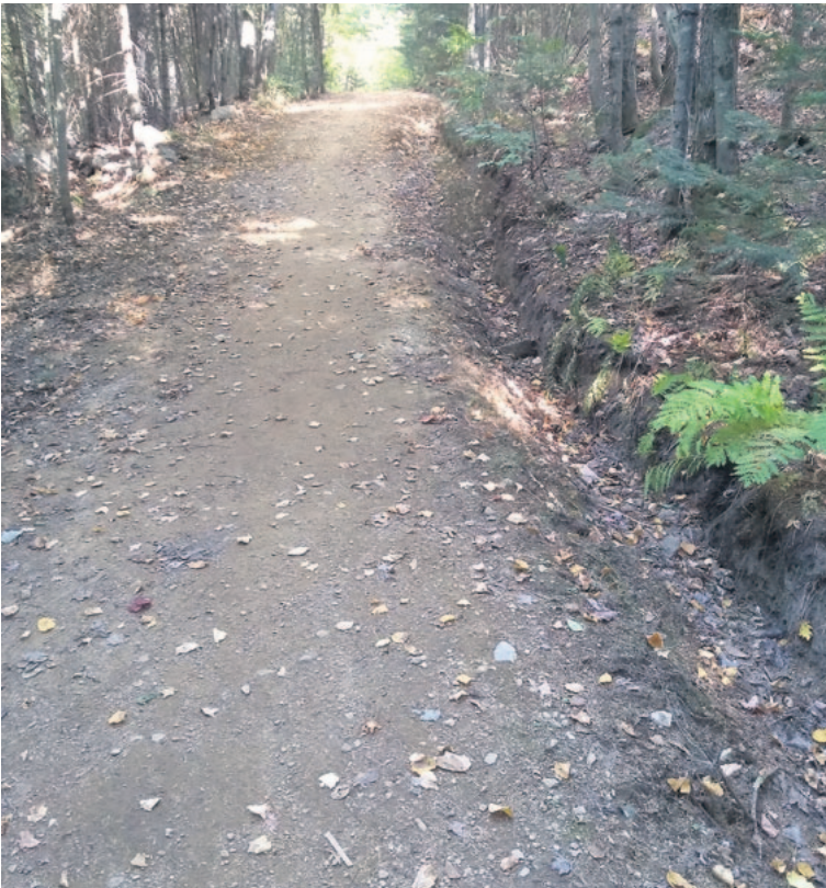
Remblai du sentier par mini-excavatrice à partir d'un fossé en bordure du sentier
