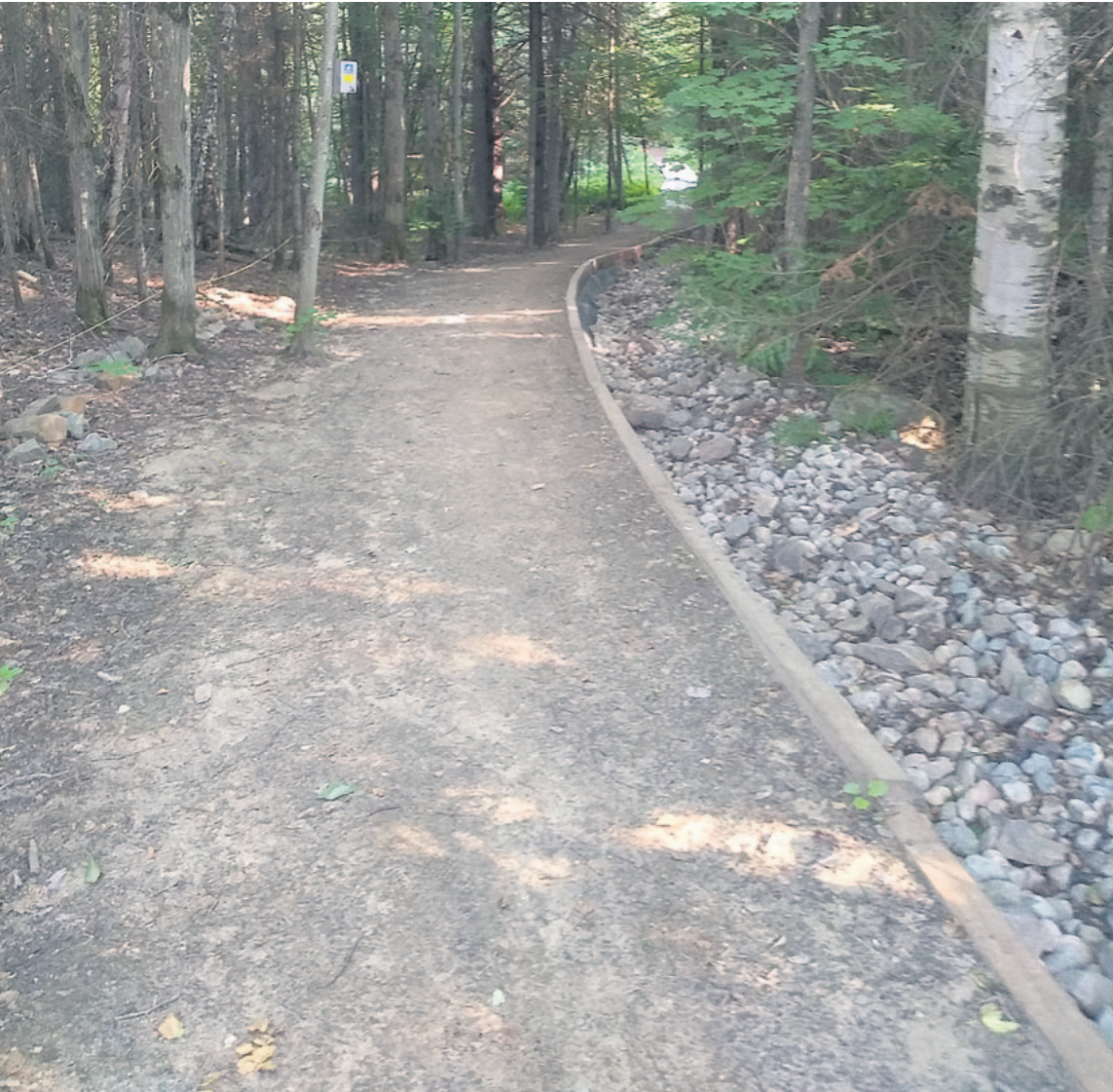
Sentier en terre livrée sur place. Le fossé a été tapissé de cailloux de rivière pour freiner l'érosion
