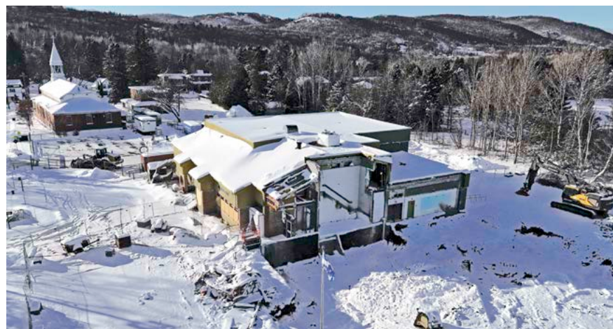
Les travaux sont commencés : première étape, le nettoyage et on conserve le gymnase.
