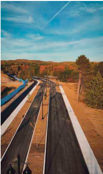
Resurfacement de rues
