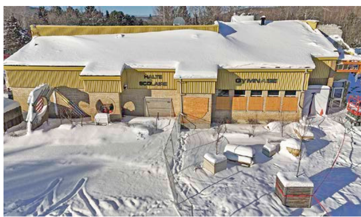
Le gymnase original de l'école Val-Des-Monts sera conservé et les travaux nécessaires seront terminés à la fin de cette année scolaire.
