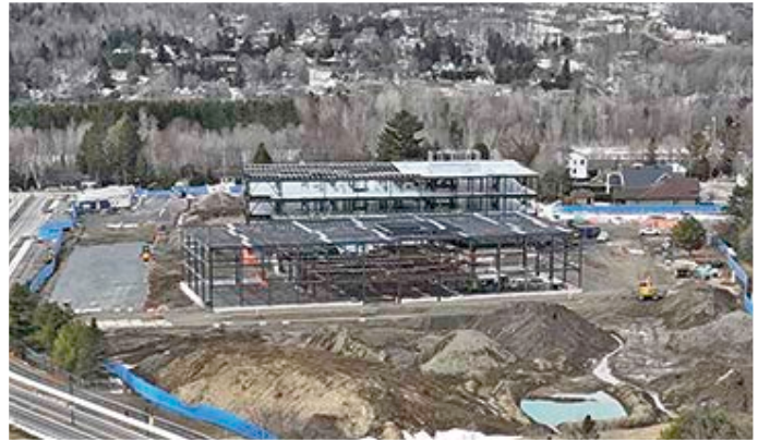
Le chantier où l'on peut voir la future école secondaire en cours de construction.
