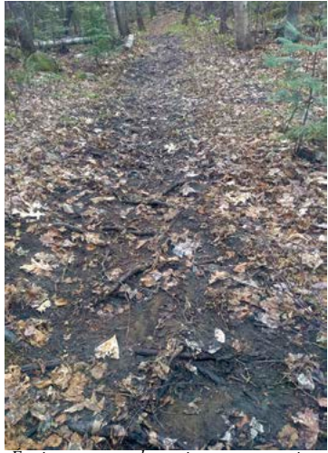
Erosion au centre du sentier: travaux majeurs à céduer.
