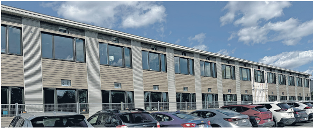
Des travaux en cours afin de terminer le revêtement de la façade de l'école Val-des-Monts.
